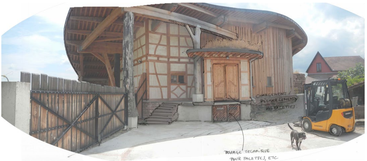
Vue du nouveau bâtiment depuis la cour
