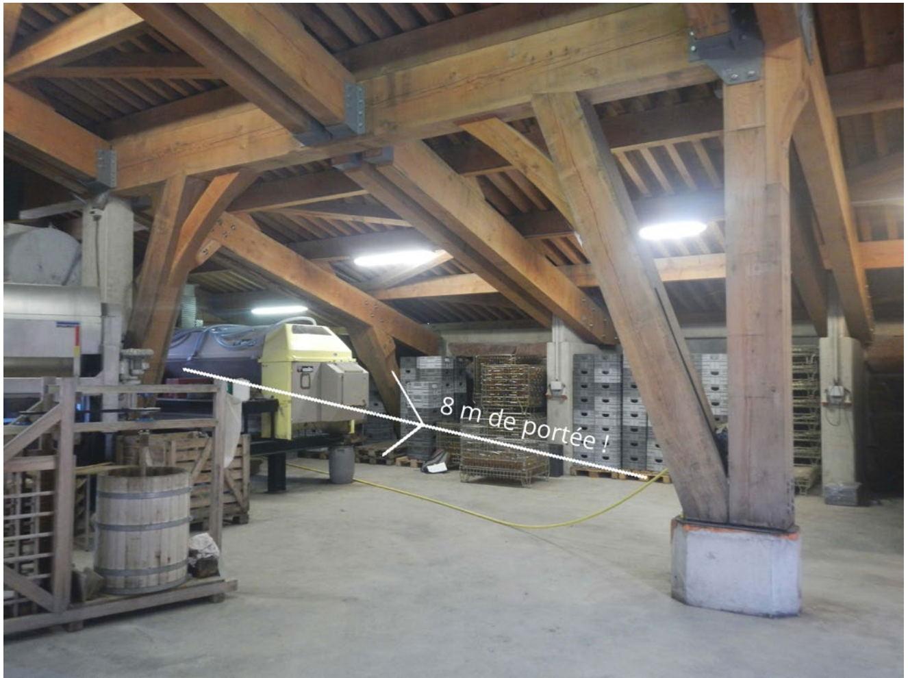
Pas de lamellé collé dans le chai, mais pas de poteau au milieu non plus !
