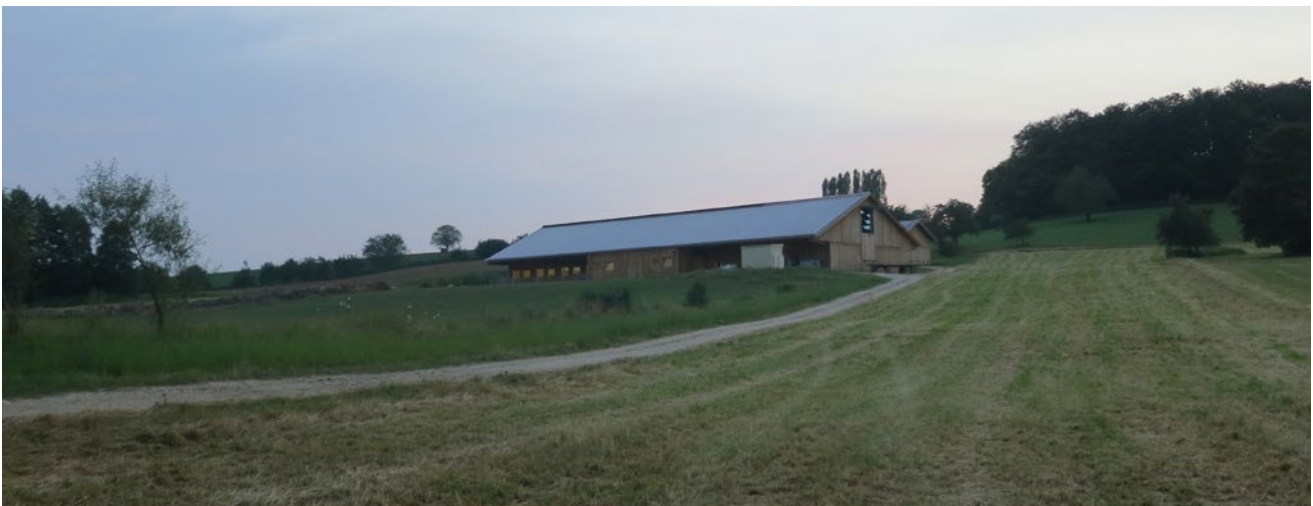
Vue d'ensemble du nouveau bâtiment
