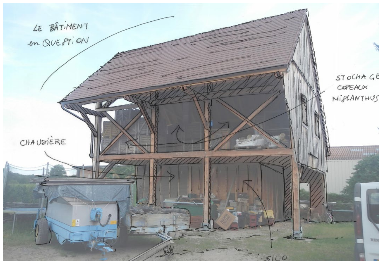
Le nouveau bâtiment abritant la chaudière et un espace de stockage à l'étage
