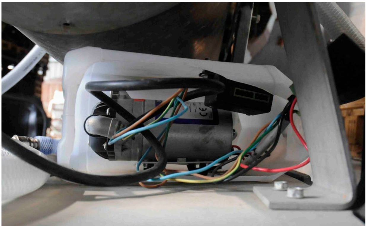
La pompe et le régulateur sont protégés des éclaboussures par un simple bidon coupé
