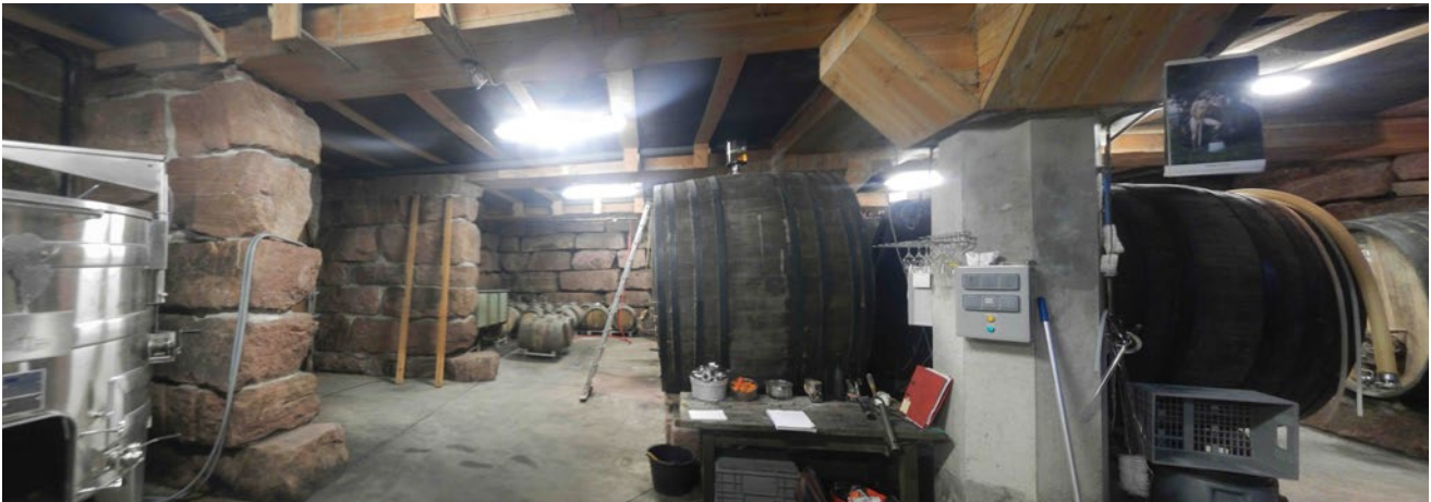
Vue de la cave et de sa structure mixte : murs en enrochements + poteaux-poutres béton-armé
