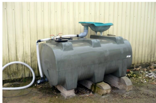
Brassage d'eau stockée avec Dynam'O (une vasque) dans une cuve de rétention de 3000 l. Dérivation pour remplissage du pulvérisateur.
